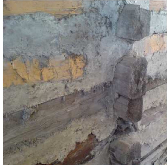
Detaljfelt fra yttervegg mot vest.
