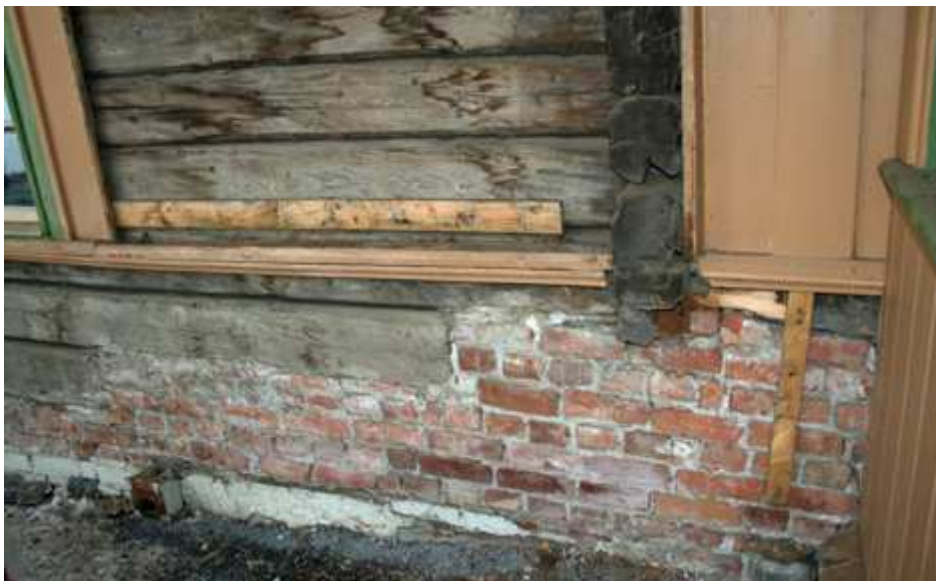
Reparasjon med tegl fra ca 1905.
