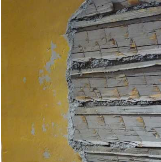
Detaljfelt fra innvendig vegg i rom mot nord/øst
